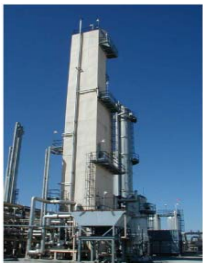
Small liquefaction Bio LNG
