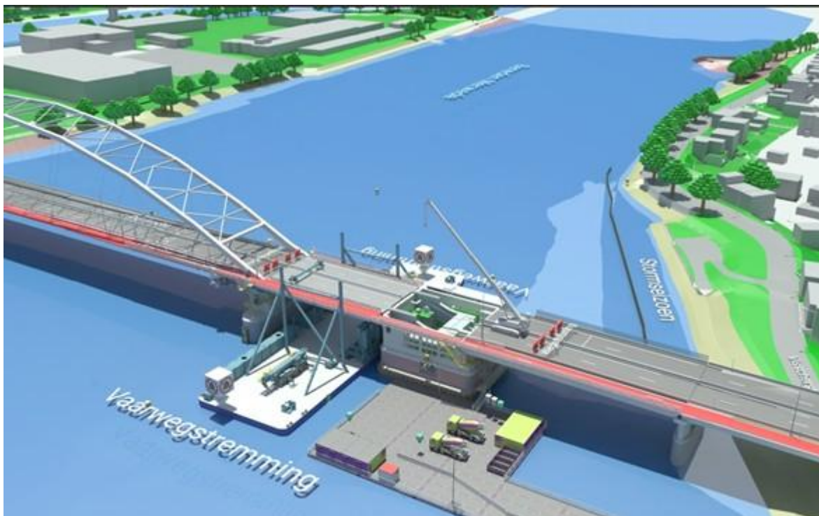
Figuur 2: de situatie voor in uit- en invaren van het brugval waarbij de vaarweg volledig is gestremd.
