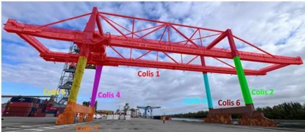
Figure 4 : Découpage du portique n°103 en sous-ensembles ou colis pour l'opération de dépose
