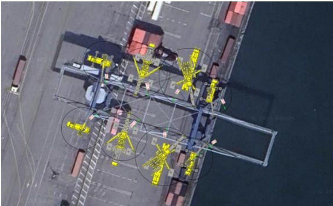
Figure 3 : Vue aérienne du portique n°103 avec implantation des grues pour l'opération de dépose
