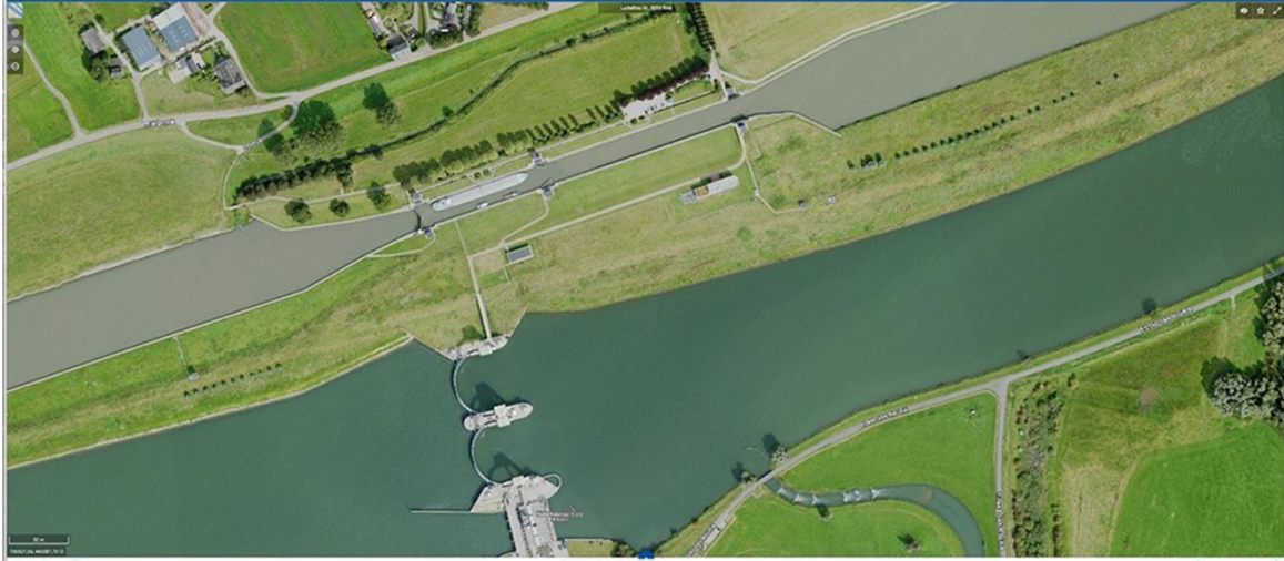
Figure 2 : Photo aérienne du complexe de barrage-écluse d'Amerongen
