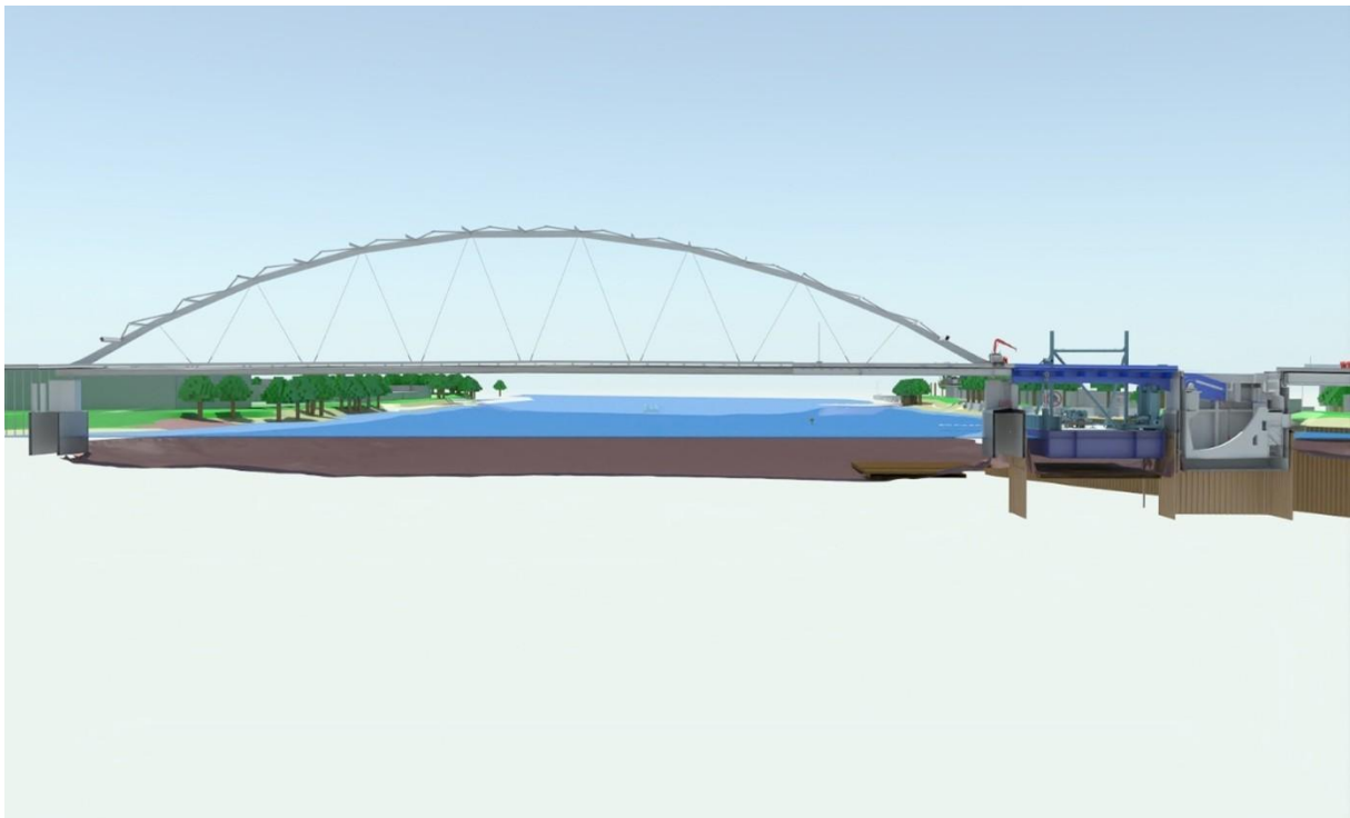
Abbildung 3: Seitenansicht mit Sohlprofil. Die Situation der Arbeiten zum Aus- und Einschwimmen der beweglichen Brücke wurde in dieser Abbildung mitberücksichtigt.
