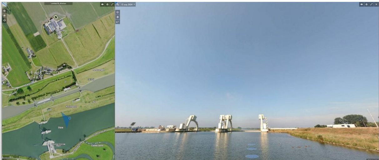
Abbildung 4: Stauwehranlage Amerongen an der Seite stromaufwärts
