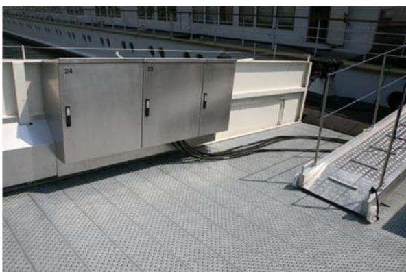
L'armoires de raccordement (côté eau) contient trois possibilités de raccordement LAN offrant aux bateaux à passagers un accès gratuit à l'Internet.
