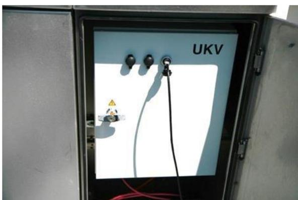
Vue intérieure de l'armoire de raccordement ouverte, avec les trois raccords LAN (par bateau à passagers), dont l'un est en cours d'utilisation.
