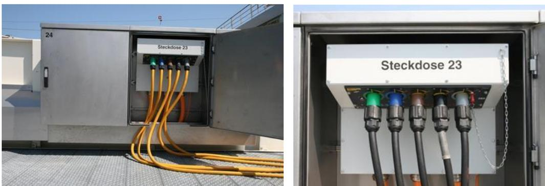
Câble Powerlock standardisé dans l'ordre correct de gauche à droite.
