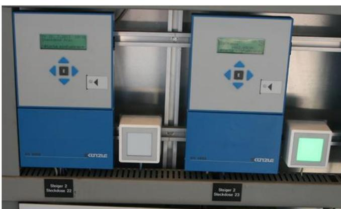
L'alimentation en courant électrique peut être activée au moyen d'un compteur d'impulsions de courant dans l'armoire destinée à l'affectation des coûts.
