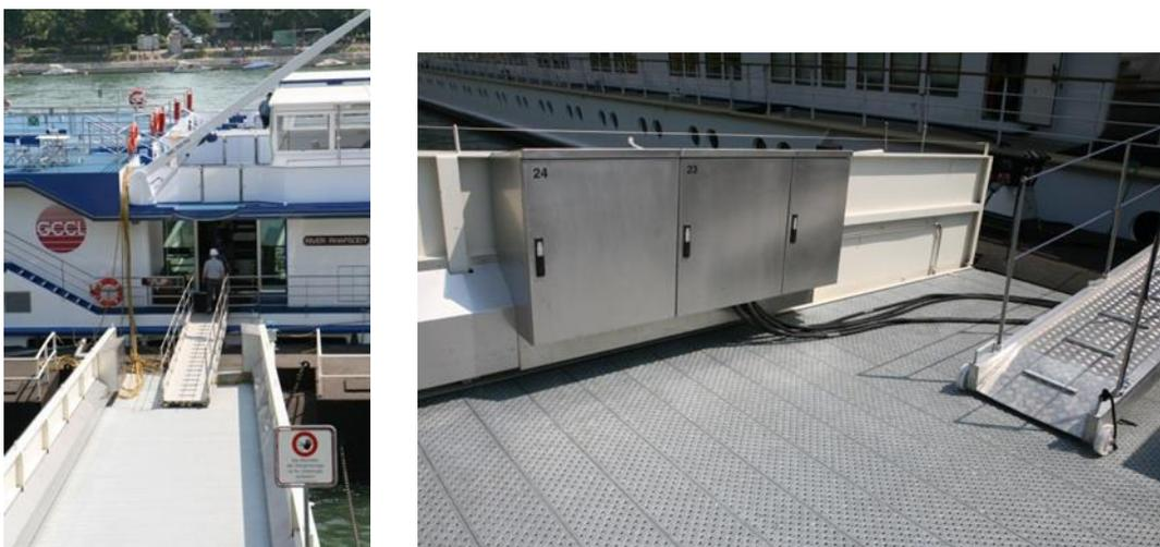
Cela évite aux équipages de devoir poser des câbles de raccordement longs et lourds. En cas de double occupation des postes d'accostage, la longueur des câbles de rallonge est suffisante pour que le bateau stationné côté eau puisse également être raccordé au réseau électrique à terre.
